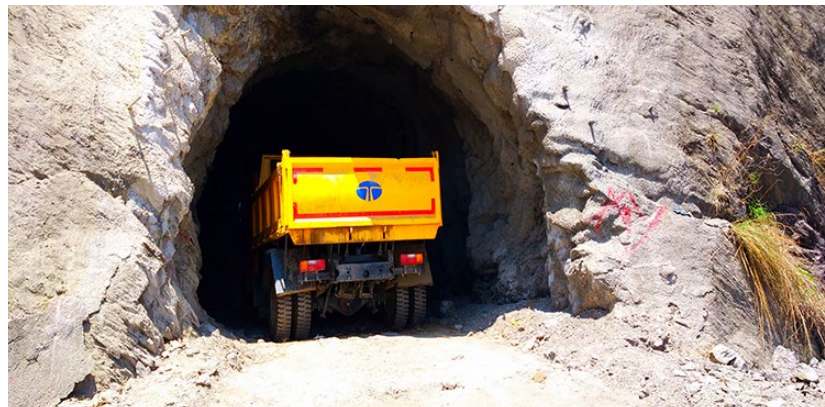
रसुवा जिल्लाको विलिमेमा रहेको सान्जेन जलविद्युत् आयोजनाको निर्माणधिन सुरङ्गमार्ग।
