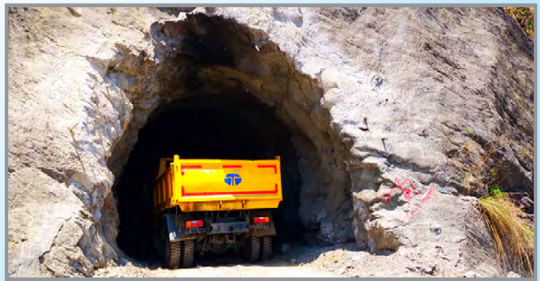
रसुवा जिल्लाको चिलिमेमा रहेको सान्जेन जलविद्युत आयोजना निर्माण स्थल र निर्माणाधिन सुरुङ्गमार्ग ।
